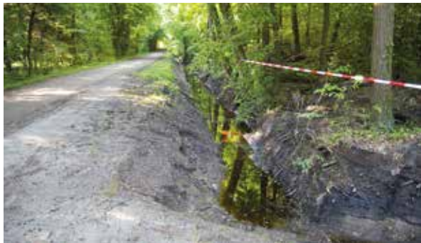
Unsachgemäß durchgeführte Grabenräumungen tragen zur Gefährdung kleiner Bergmolchpopulationen bei
